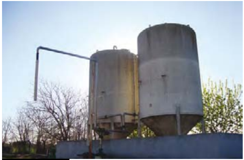
Tanques de Uan en Planta II.
