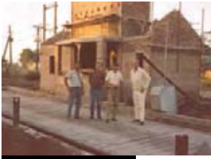
Construcción de Planta 1 en Carlos Casares, a principios de la década del 80. De izq. a der.: "Cacho" Campagna, Miguel Mallofré, Juan Baldoyra y Adolfo, todos continúan trabajando en Los Grobo.
